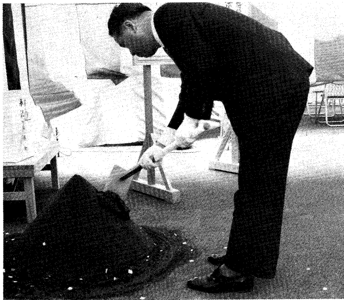
複合施設新築工事(地鎮祭)で町長による鋤入の儀
