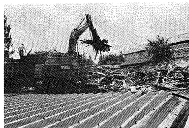
とり壊し作業のようす
