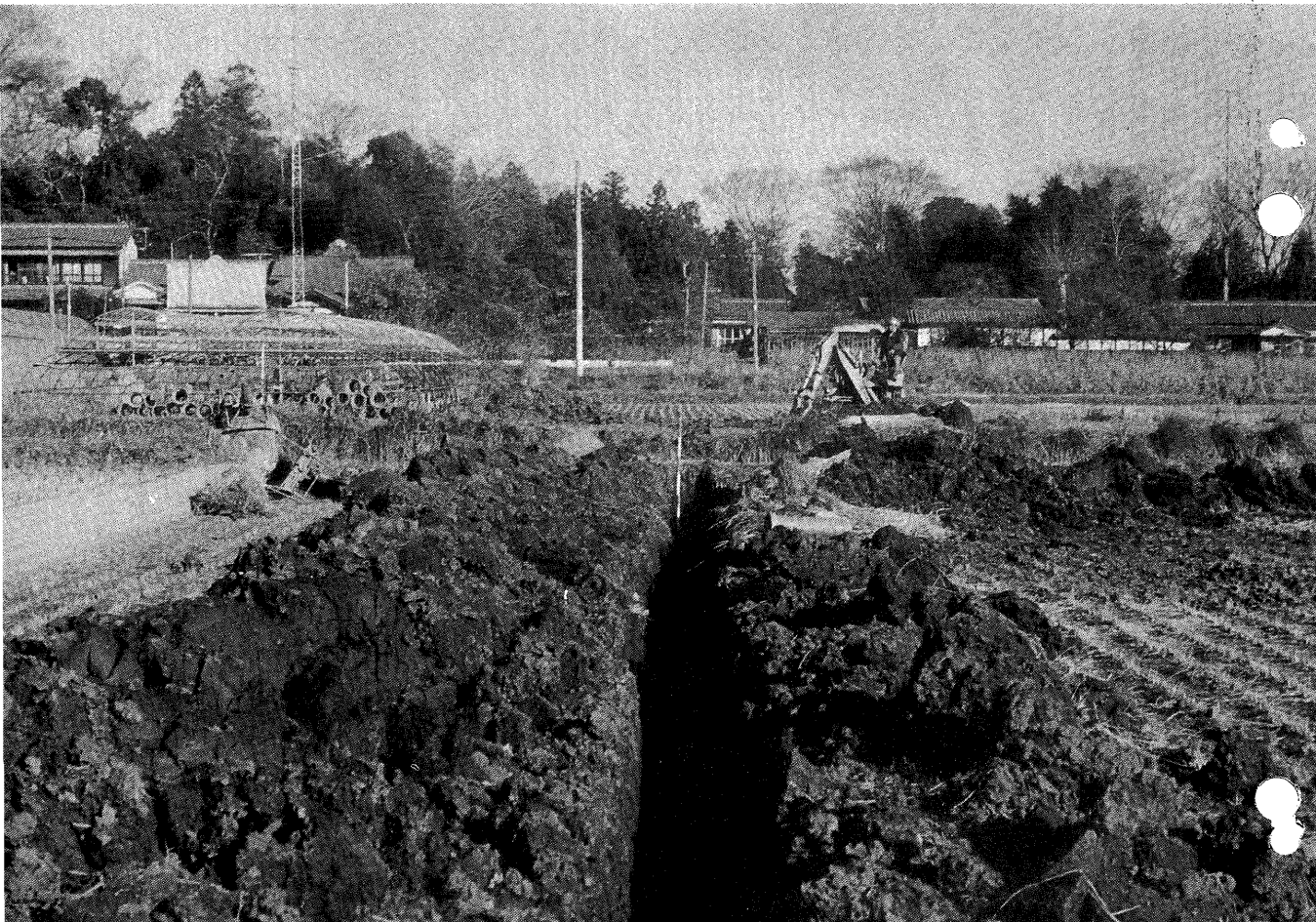
(須賀広地内の工事現場)
