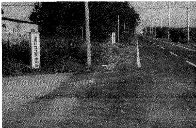
完成した村道九号線
