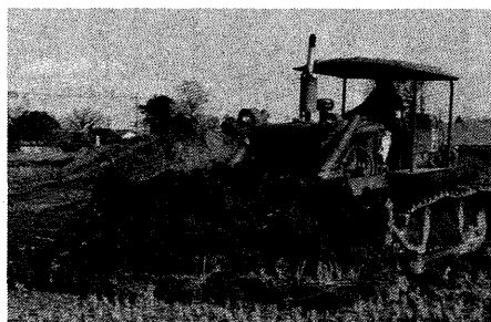
整地工事進む御正新田地区
