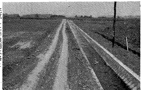
完成した幹線用水路と農道および圃場
