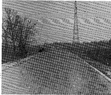
荒川堤防下段兼用道路舗装工事完成長さ2.456m
