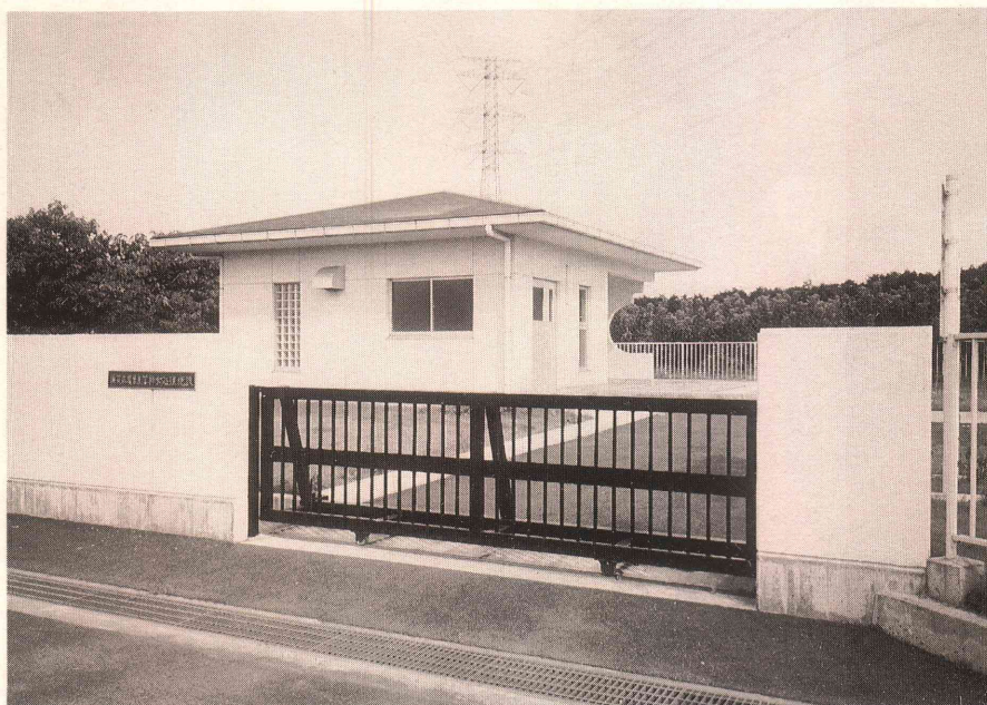
須賀広農業集落排水処理施設
