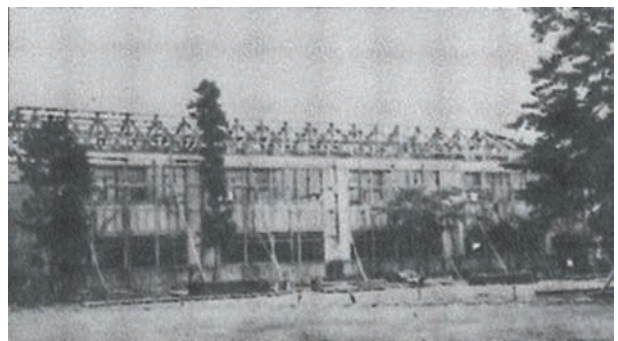
3 元素楼（校舍解体時）
