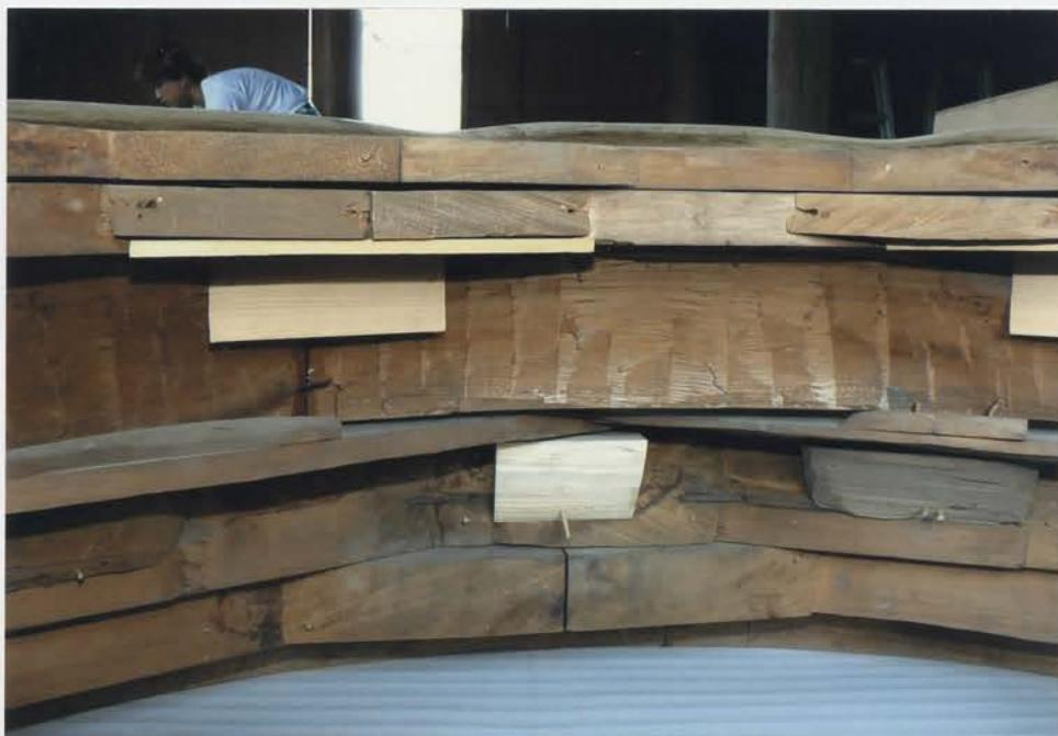
板材や角材が各段同士のずれ止めや各部補強材として使われていた。新材部分が今回既設の補修箇所。
