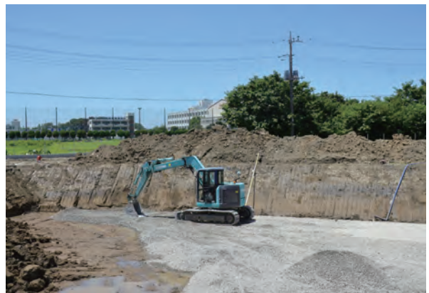
8 同左工事掘削状況
